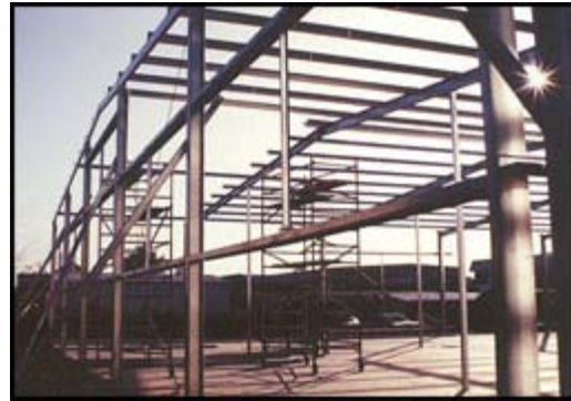
(d) Industrial sheds
